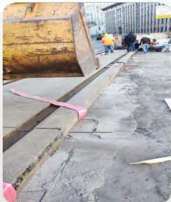
Монтаж плит блочной конструкции трамвайного пути, с подливкой и инъектированием высокотекучего расширяющегося цементного вяжущего
