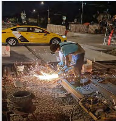
Сварочные работы осуществляются несколькими мобильными группами с использованием специального оборудования для улучшения геометрии пути и проведения термитной сварки..
