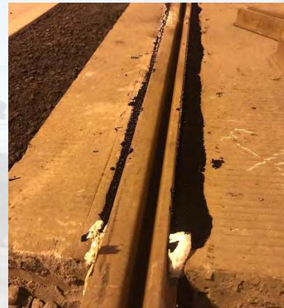
Фиксация рельса ЛК1 в профиле путем заливки эластомерным герметиком на полиуретановой основе
