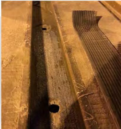
Вклейка нижнего резинового профиля при помощи эпоксидного клея
