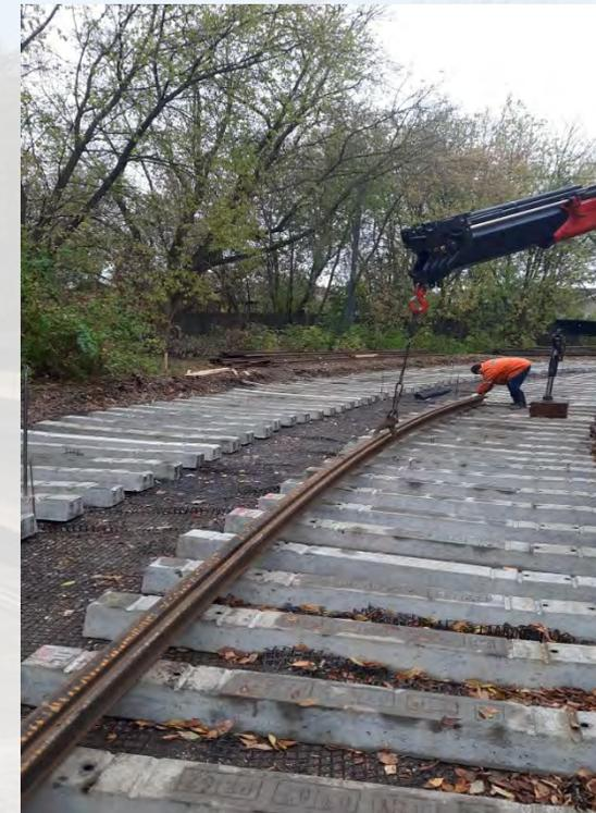
Укладка криволинейных участков пути на ж/б шпале ШТ-03 с радиусом кривой 140м и 50м.
