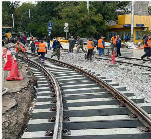
Укладка криволинейного участка пути с трамвайным рельсом РТ62 и композитной пластиковой шпалой
