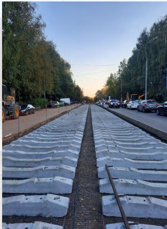
Уложен прямолинейный путь на ж/б шпале с рельсом типа Р65,
