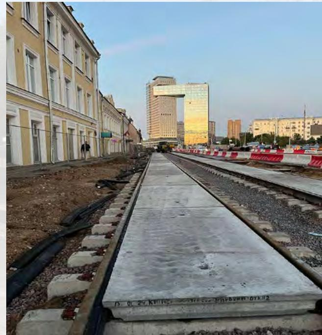
Новое строительство трамвайного полотна по улице Сергея Радонежского включает в себя прямолинейный участок пути на шпалах ШТ-02 с типом рельс Р 65, криволинейные участки пути на шпалах ШТ-03, стрелочные переводы на ж/б брусках с прямоугольными тягами и закладным креплением, стрелочные переводы с автоматикой элементами обогрева и гибкими острьяками, а так же спецчасти (ромбы) и 2 глухих пересечения в местах действующей трамвайной линии.
